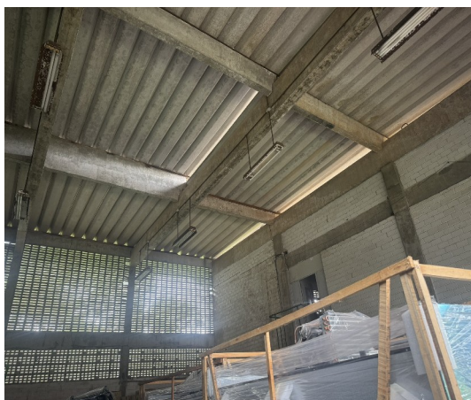
Figura 06 – Luminárias quebradas e enferrujadas e Figura 07 – Piso sujo
