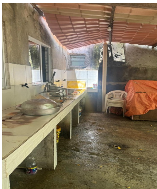
Figura 18 – Local em reforma no Terreiro de Lembá
